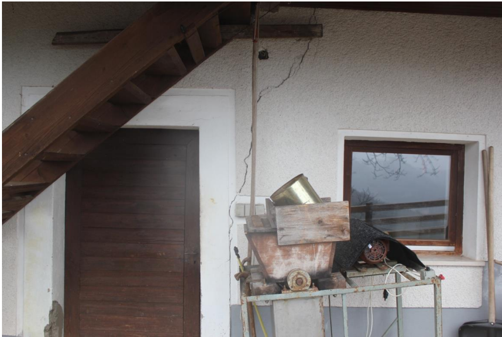
Poškodbe na gospodarskem objektu
