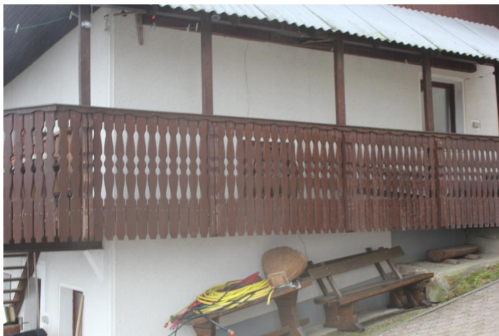
Poškodbe na stanovanjskem objektu
