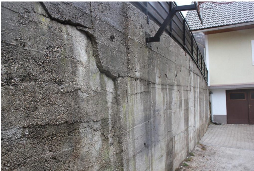
Pogled na strižno zamaknjen in nagnjen zid med hišami 3 in 3a
